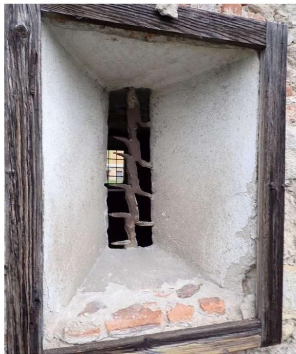
Kellerfenster aus wiederverwendeten Kalksteingewände (Spolien) mit Steckgitter und Scharfenfenster mit Zackenstäben und später angebrachten Holzfenster.
